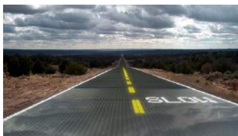
Рисунок 2. Пример использования «умных «солнечных батарей. Проект Solar Roadways
